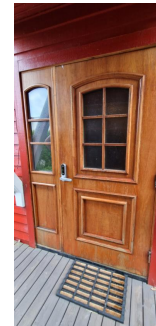
19,5% - Høyere fuktmåling en ønsket. Påregn til
