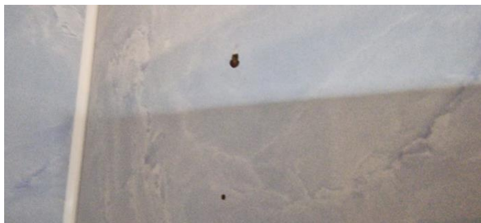
Små silikonerte hull i våtromsplater på bad.
