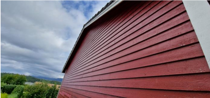
Utskifta bord pga. tidligere påvist råte, borda ble males i 2022 iht. tidligere eier.
