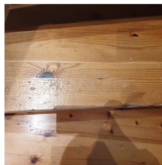
Noe merker på trinn til trapp.
