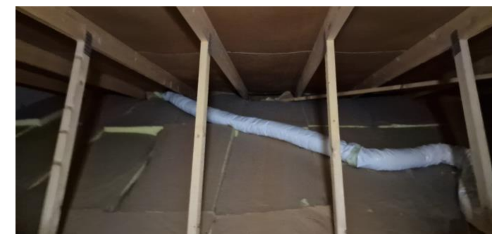
Isolerte ventilrør.
