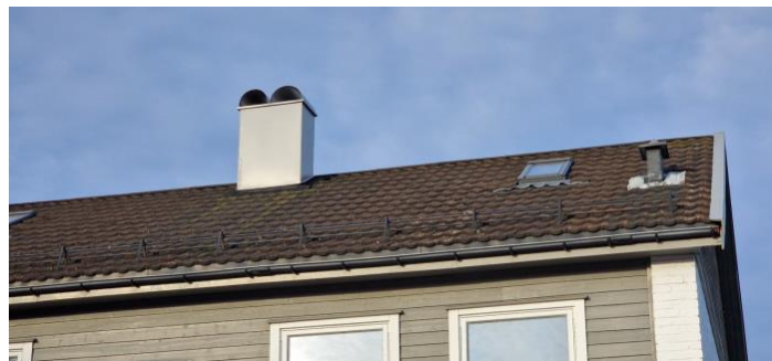
Heldekkende pipehatt over taket.
