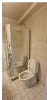
Toalett og dusjkabinettet til badet.
