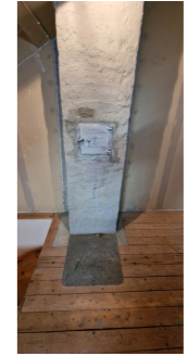
Sotluke ved kaldloftet, ildfast plate over tregulv.
