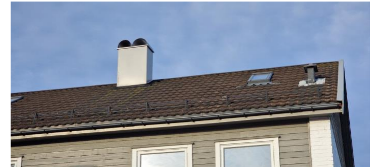
Heldekkende pipehatt over taket.
