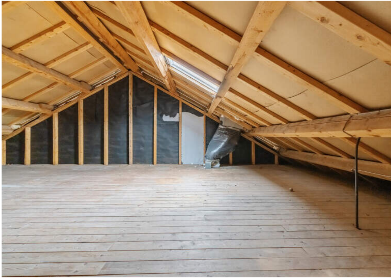
- Uinnredet loft med 39m2 gulvareal -
