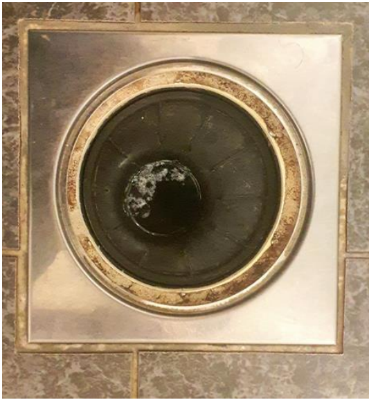
Våtrom - [Sluk, bad ]
