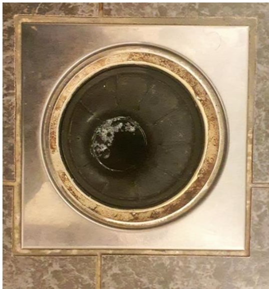
Våtrom - [Sluk, bad]
