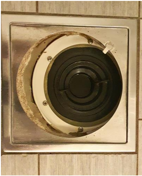
Våtrom - [Sluk, bad]
