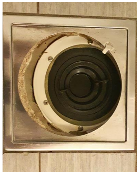
Våtrom - [Sluk, bad ]
