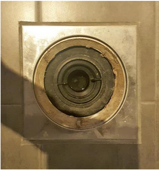
Våtrom - [Sluk, bad ]
