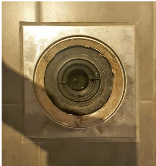
Våtrom - [Sluk, bad ]
