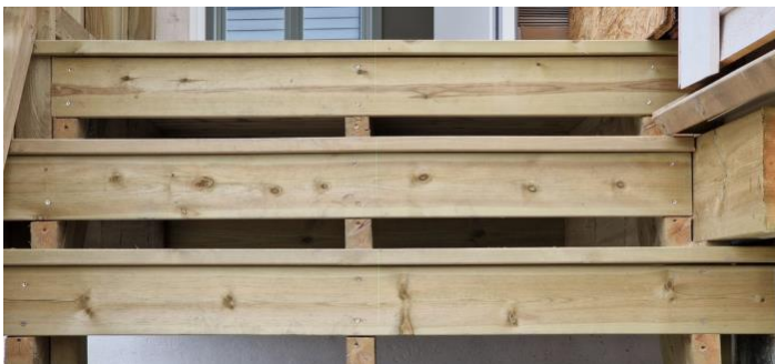
Grønn laser er i flukt nede ved tretrappen og ca. 2.5 cm ut fra tre-støtten under inntrekk.
