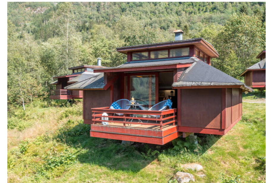
- Alle hyttene får installert egen strømmåler i forbindelse med salget -
