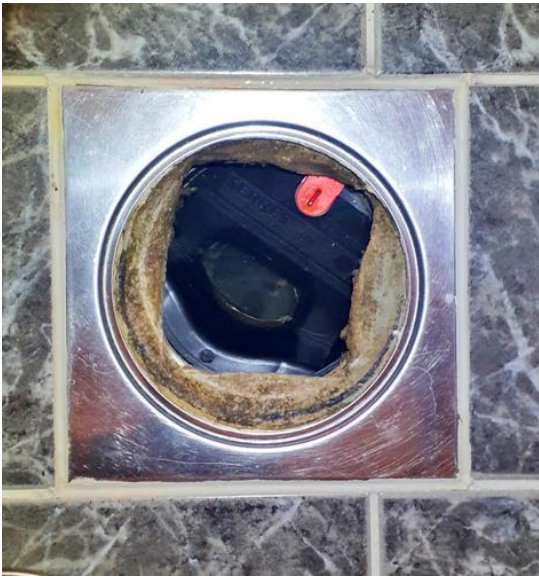
Våtrom - [Sluk på bad, 2. etasje ]
