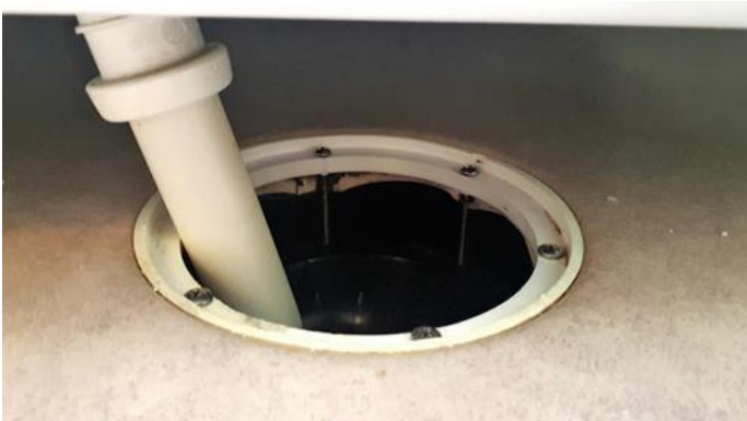
Våtrom - [Sluk på bad 3. etasje ]
