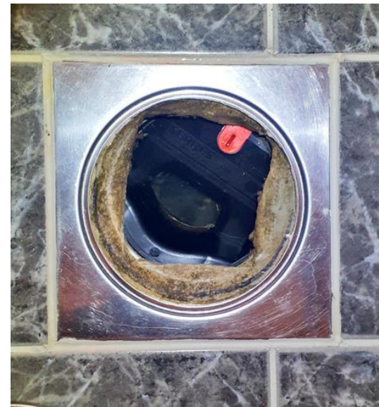
Våtrom - [Sluk på bad, 2. etasje]
