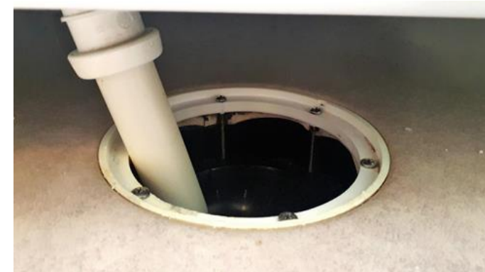
Våtrom - [Sluk på bad 3. etasje]
