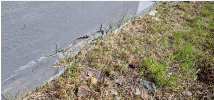
Enkelte områder med murpuss har løsnet utvendig. Samt sprekker. Det må påregnes tiltak.
