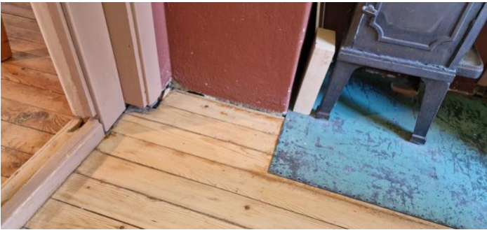
Ved pipe på loftet.
