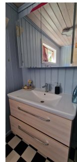
Innredning med vask og speil. Eier opplyse om små riss på vask.
