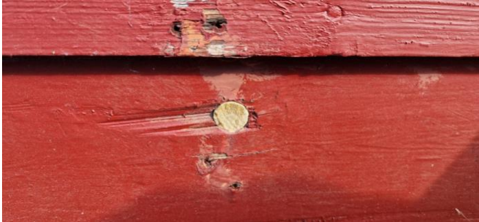
Påregn tiltak på ferdigstilling av tidligere gjennomgang for varmepumpe.
