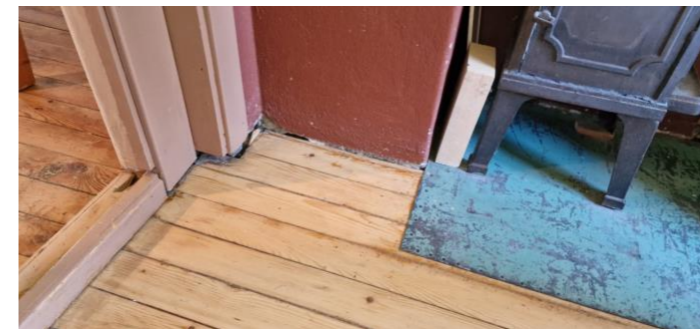
Ved pipe på loftet.
