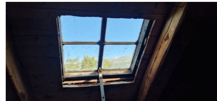
Eldre jern-vindu ved kaldloftet.
