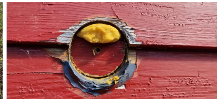
Påregnet tiltak på ferdigstilling av tidligere gjennomgang for varmpumpe.
