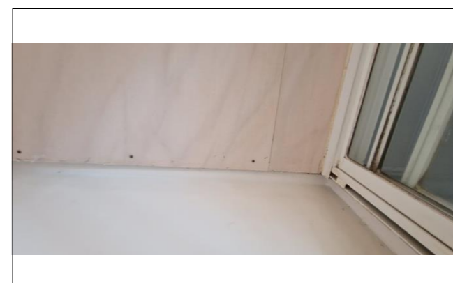
Skruer i nedre kant av våtromsplater inni dusjonen ved badet i 1.etg.
