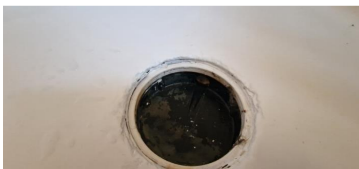
Malt gulv i dusjonen, eller ikke membran iht. omviser. Plastsluk.
