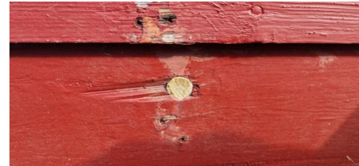
Påregnet tiltak på ferdigstilling av tidligere gjennomgang for varmpumpe.
