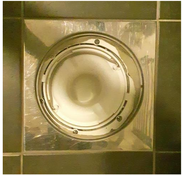
Våtrom - [Sluk, vaskerom ]
