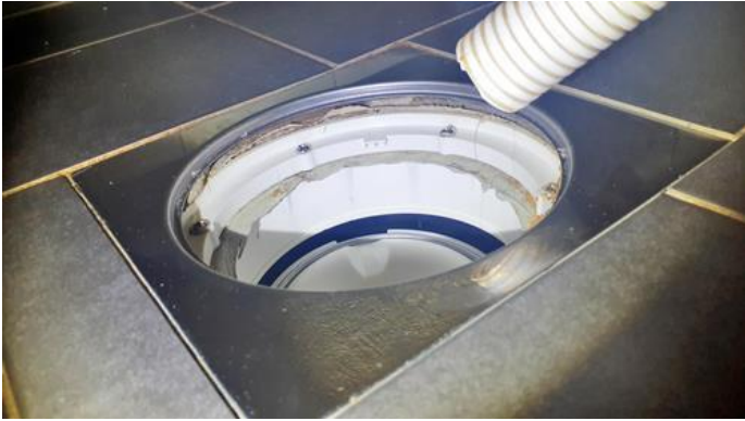
Våtrom - [Sluk, bad ]
