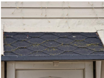
Shingeltak på overbygget ved inngangspartiet.
