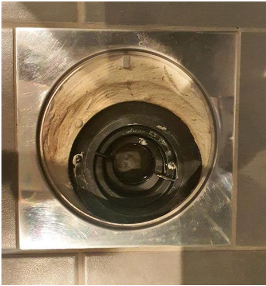
Våtrom - [Sluk, bad]
