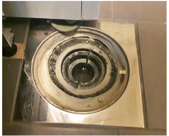
Våtrom - [Sluk, vaskerom]
