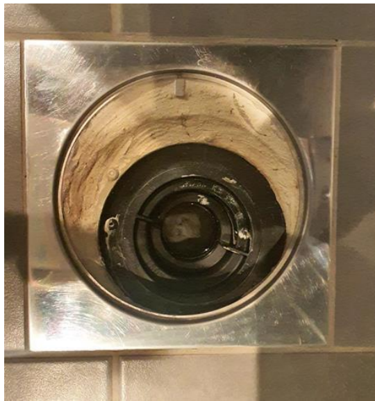
Våtrom - [Sluk, bad]
