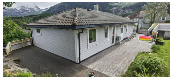
Terrasse kring huset i 1. etasje
