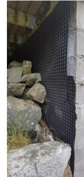
Synleg fuktsperre (knotteplast) ved utside grunnmur
