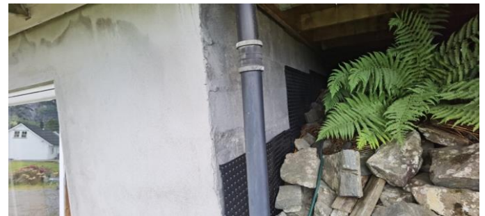
Synleg fuktsperre (knotteplast) ved utside grunnmur
