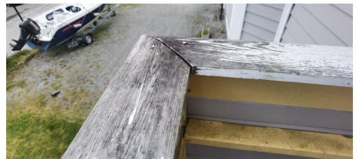
Rekkverk ved terrasse/balkong
