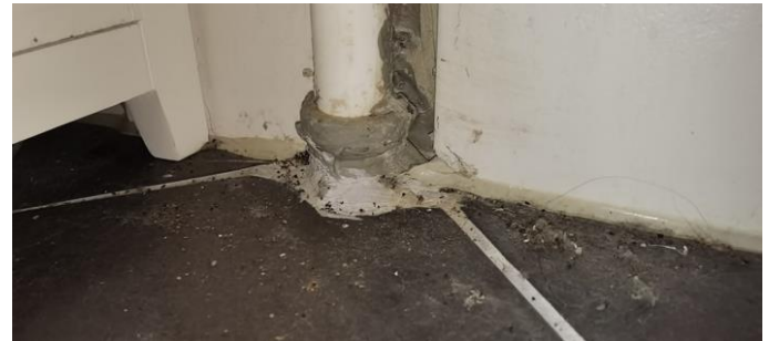
Gjennomføring av avløpsrør i golv
