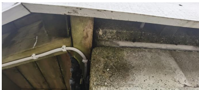
Overgang betongplate/bakvegg ved terrasse over carport i underetasje
