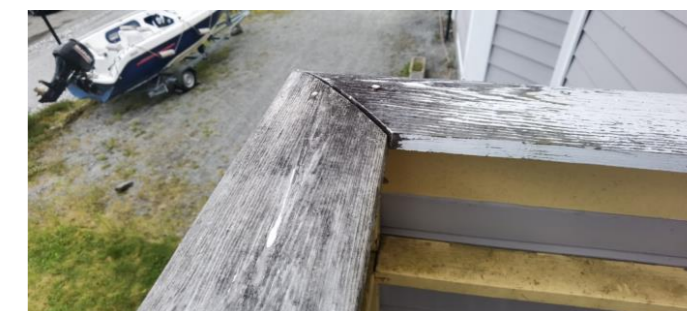
Rekkverk ved terrasse/balkong
