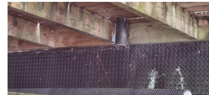
Takrennedløp avslutta utside grunnmur under terrasse
