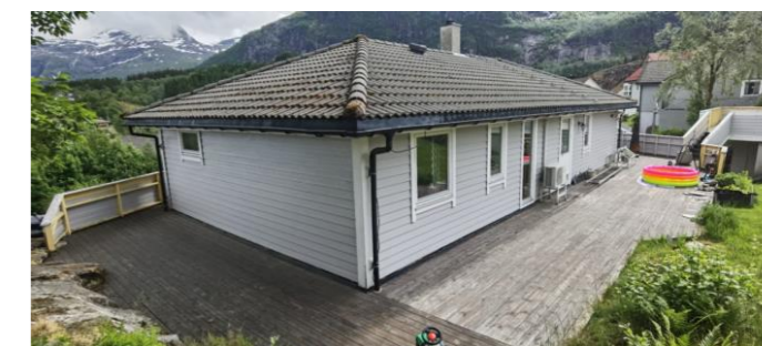
Terrasse kring huset i 1. etasje
