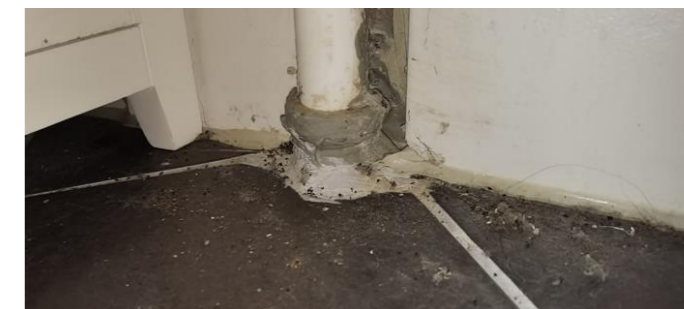
Gjennomføring av avløpsrør i golv
