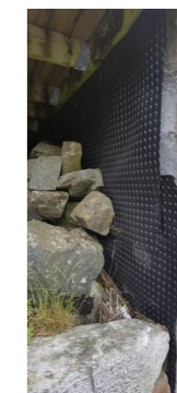
Synleg fuktsperre (knotteplast) ved utside grunnmur
