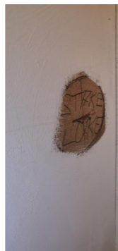
Markert innkassing ved stakeluke i underetasje
