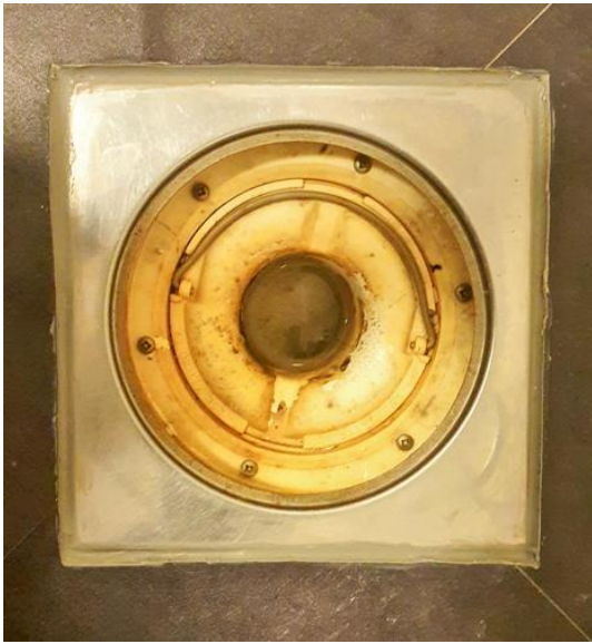
Våtrom - [Sluk, bad ]
