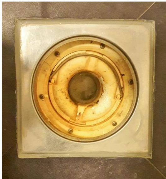
Våtrom - [Sluk, bad ]
