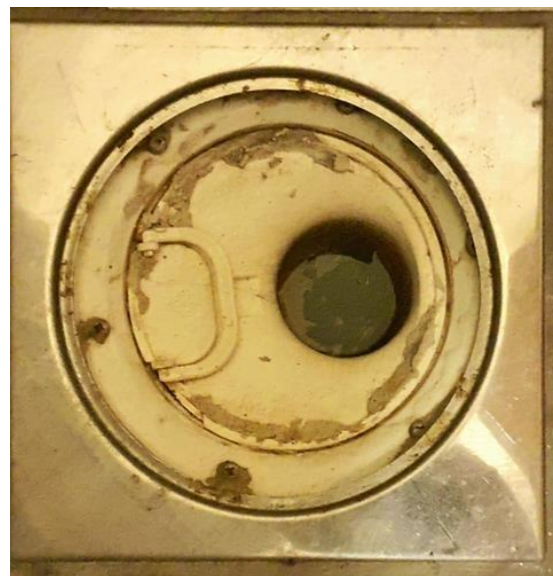
Våtrom - [Sluk, vaskerom]
