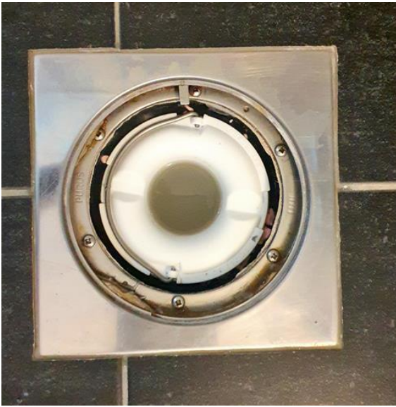
Våtrom - [Sluk, bad ]
