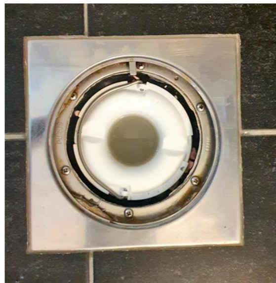
Våtrom - [Sluk, bad ]
