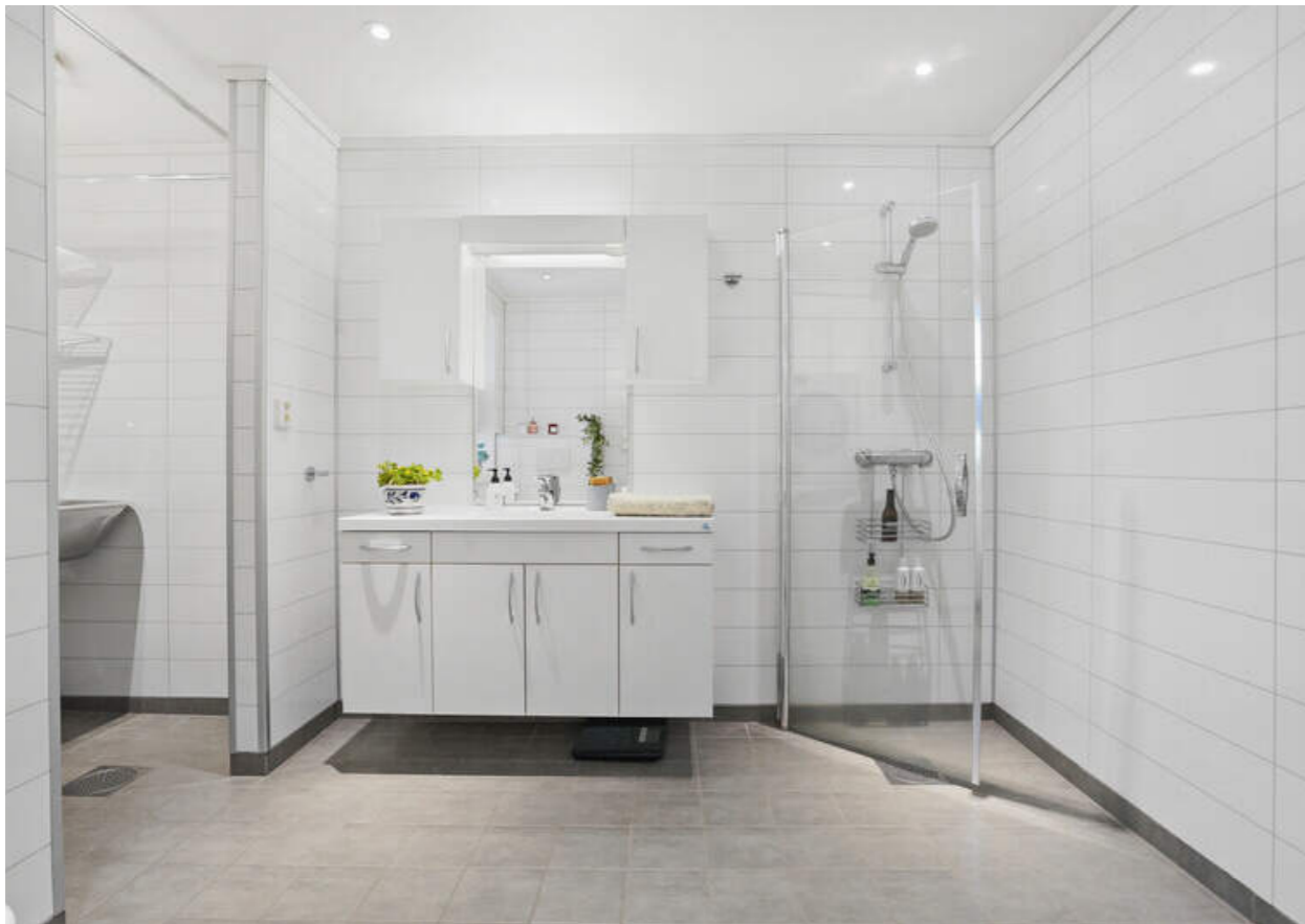
- Badet har flislagt gulv og baderomplater på vegg. I himling er det downlights -
