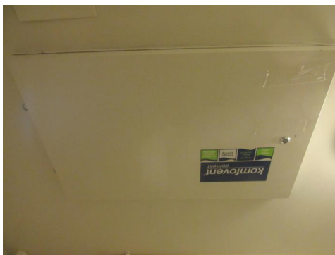
Ventilasjonsaggregat
