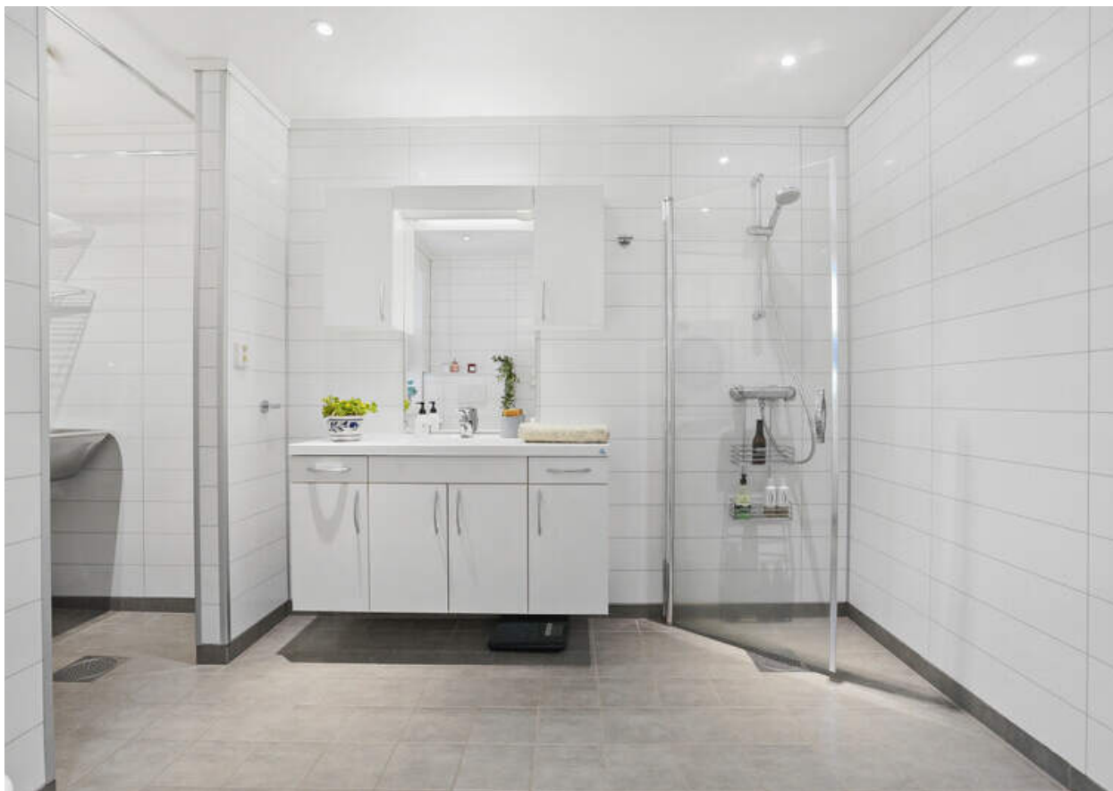
- Badet har flislagt gulv og baderomplater på vegg. I himling er det downlights -
