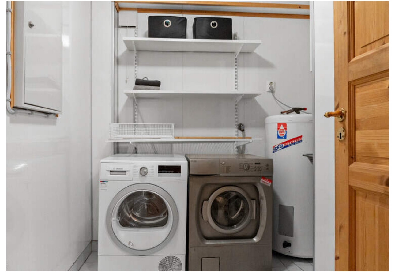
- Vegg i vegg ligger vaskerom/teknisk rom -
