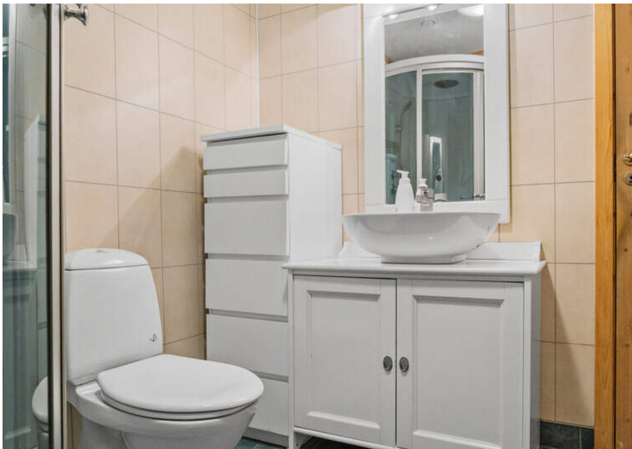
- Badet er fra byggeår med fliser på gulv og baderomsplater på vegg -
