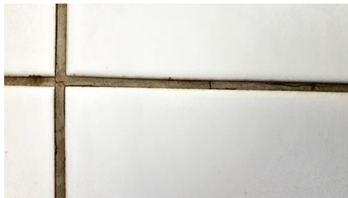
Våtrom - [Fuger, bad ]
