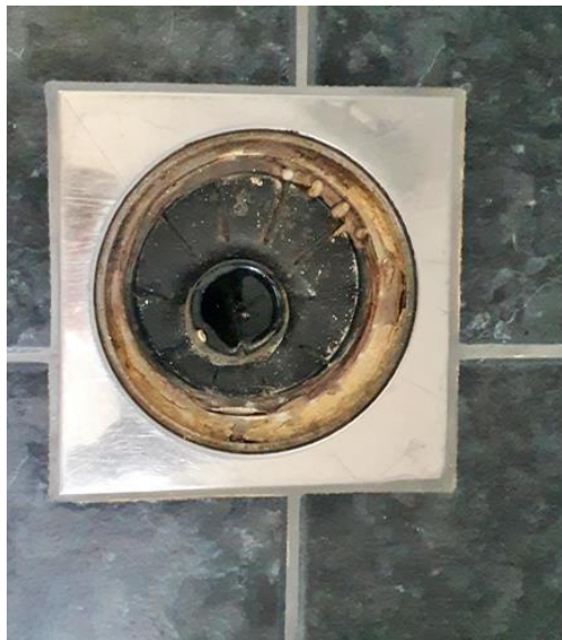
Våtrom - [Sluk, bad ]
