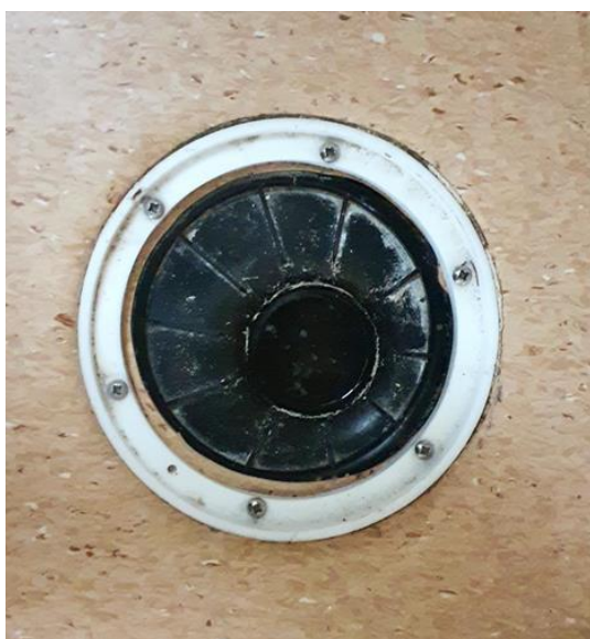
Våtrom - [Sluk, vaskerom ]
