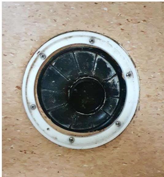
Våtrom - [Sluk, vaskerom ]
