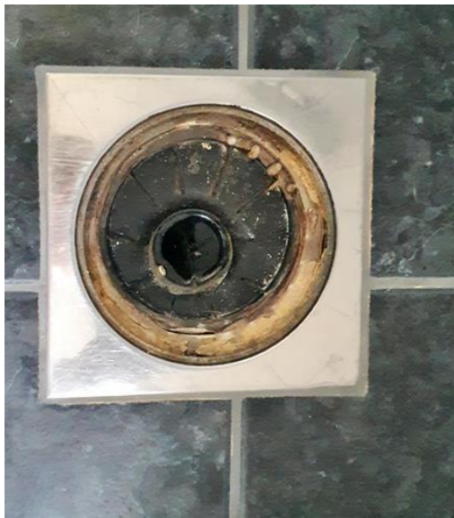
Våtrom - [Sluk, bad ]
