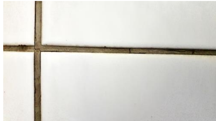
Våtrom - [Fuger, bad ]
