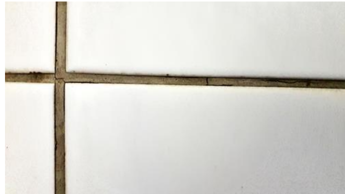
Våtrom - [Fuger, bad ]
