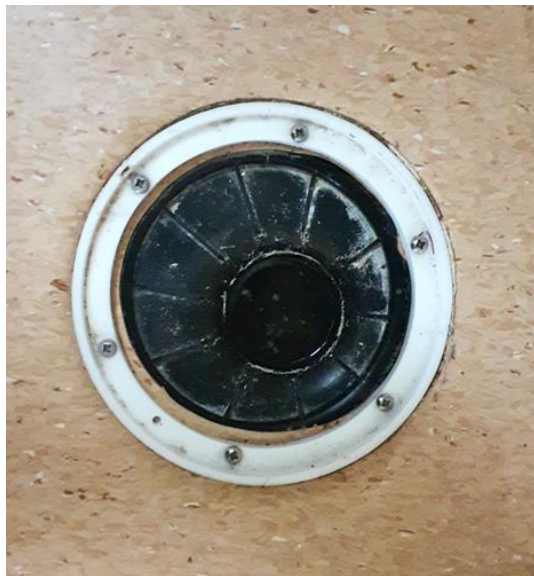
Våtrom - [Sluk, vaskerom ]
