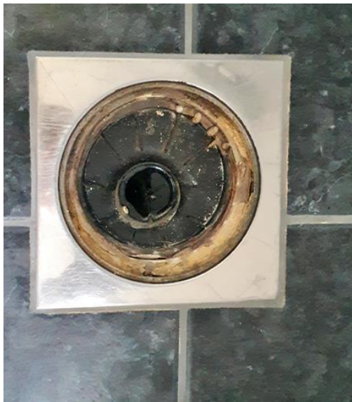
Våtrom - [Sluk, bad ]
