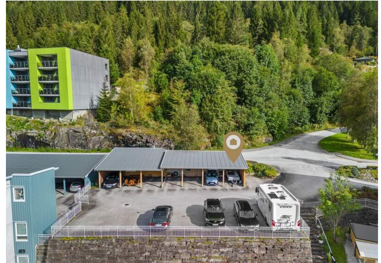
- Fast parkeringsplass i carport. Her er det tilrettelagt for montering av ladeboks til elbil -
