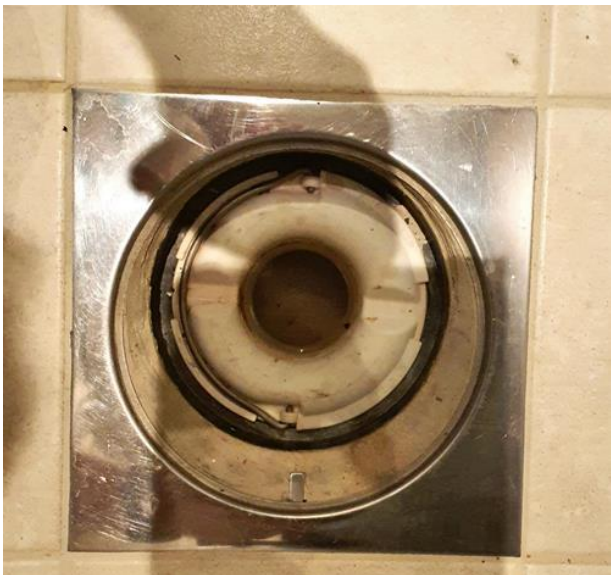
Våtrom - [Bad underetasje, sluk]
