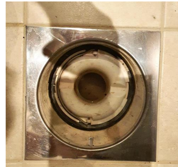
Våtrom - [Bad underetasje, sluk]
