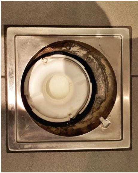
Våtrom - [Sluk, bad ]
