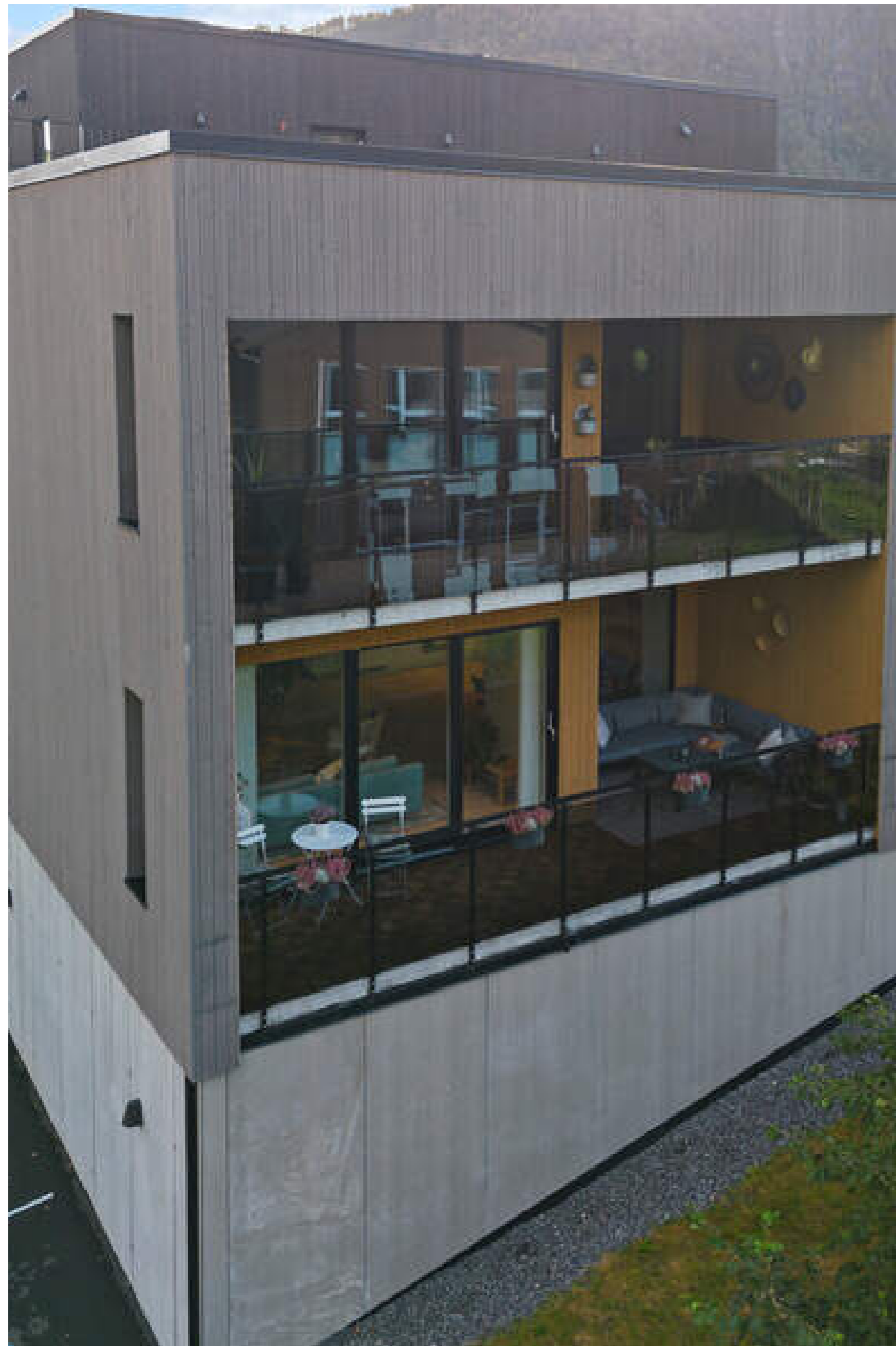
- Leiligheten ligger i byggets 1.etg -
