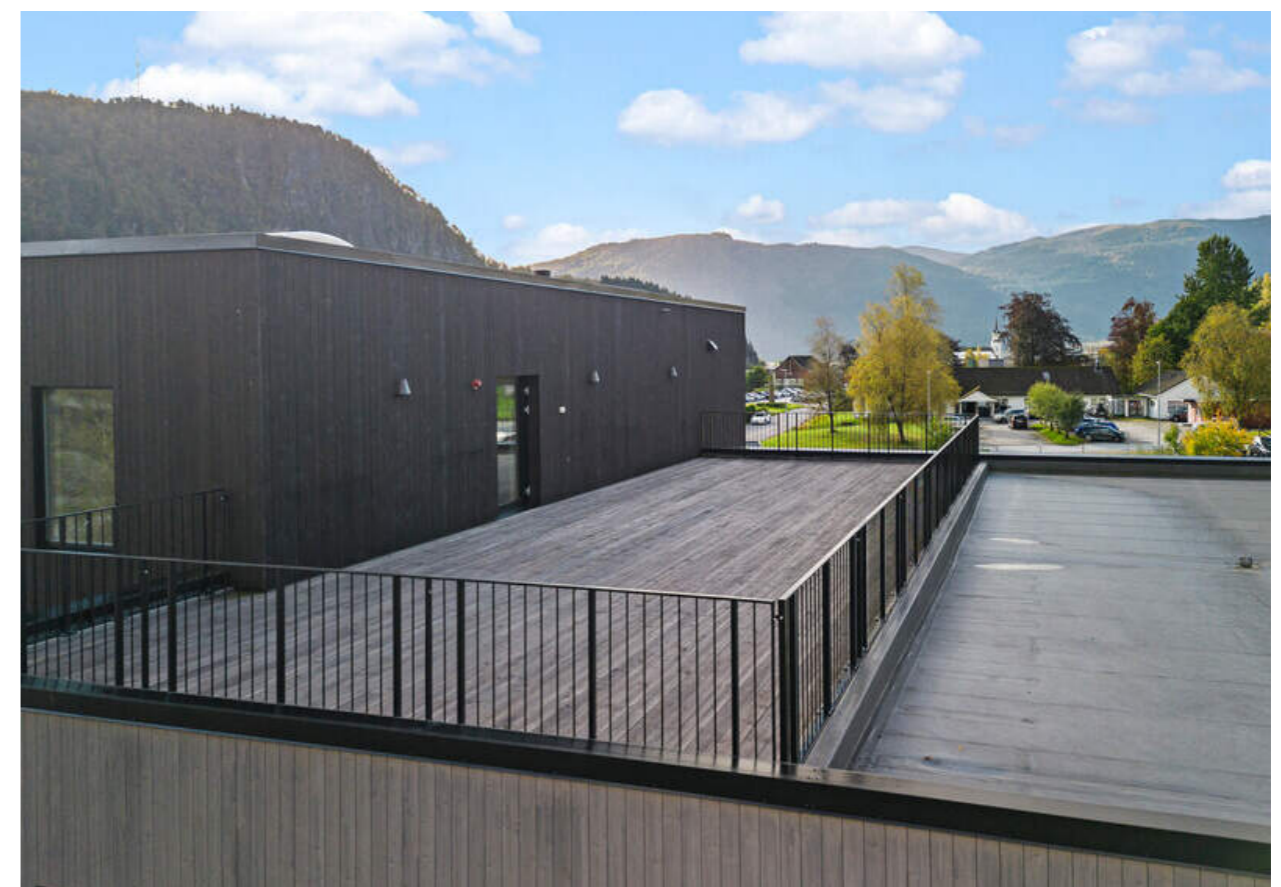
- Sameiet har tilgang på felles takterrasse med gode solforhold -
