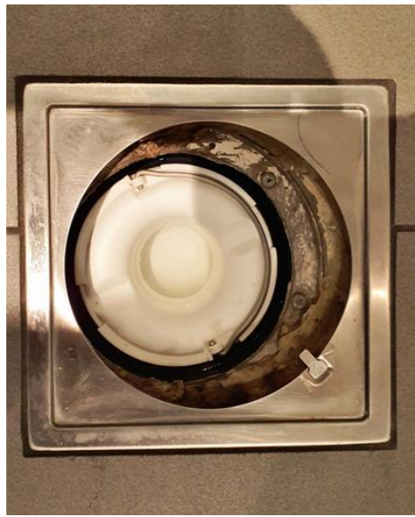
Våtrom - [Sluk, bad ]
