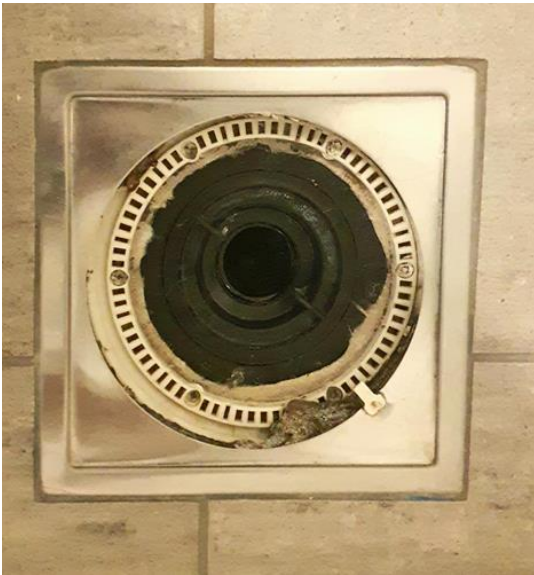
Våtrom - [Sluk, bad]
