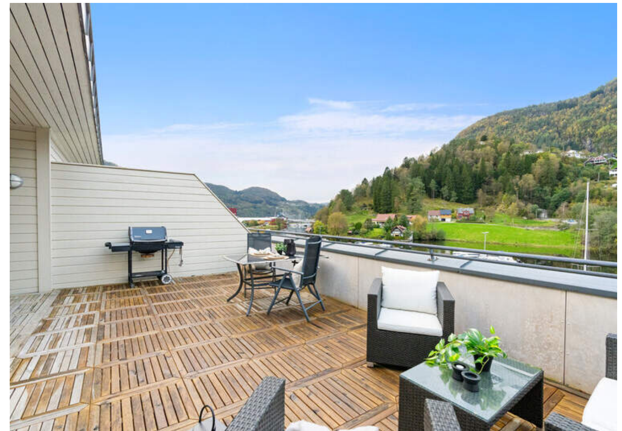
- Det er lagt nye tremmer i trevirke i ca. 2018 -
