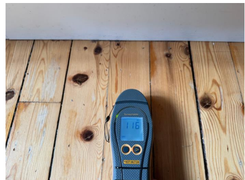
Ingen forhøyede fuktverdier ble registrert v/ utsatte områder.
