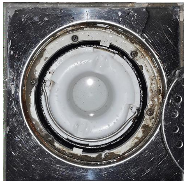
Våtrom - [Sluk vaskerom underetasje]
