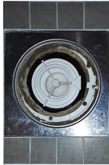
Våtrom - [Sluk bad 1. etasje]
