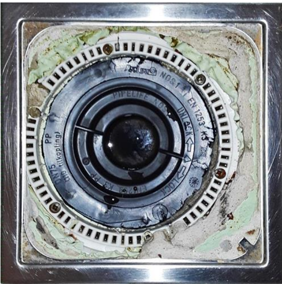
Våtrom - [Sluk leilighet i underetasje]
