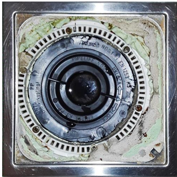
Våtrom - [Sluk bad leilighet i underetasje]
