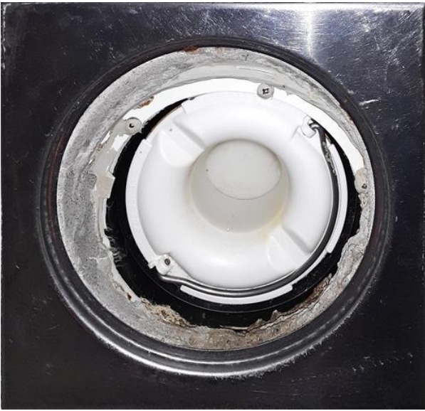
Våtrom - [Sluk bad]
