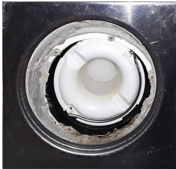
Våtrom - [Sluk bad]
