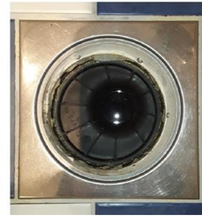
Våtrom - [Sluk - Bad underetasje]
