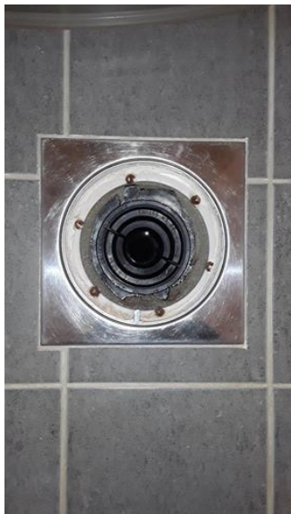
Våtrom - [Sluk bad]
