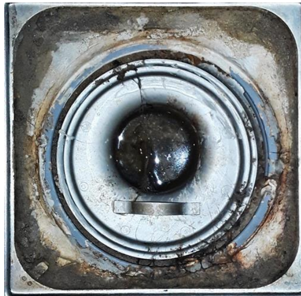
Våtrom - [Sluk bad]
