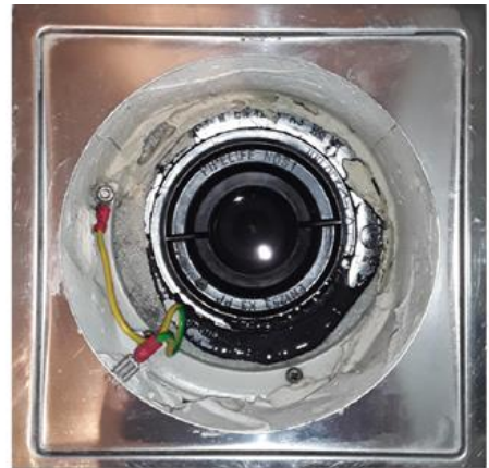
Våtrom - [Sluk - Vaskerom]
