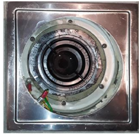
Våtrom - [Sluk - Bad]
