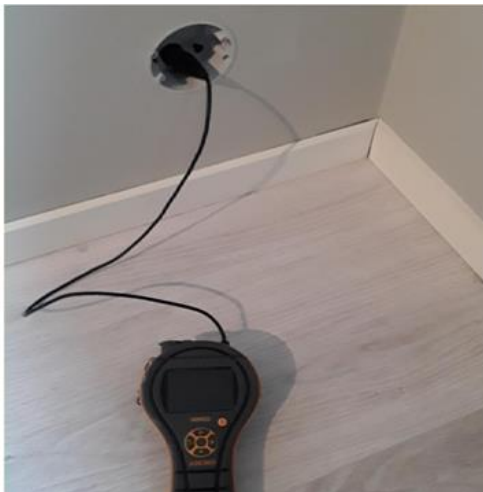
Våtrom - [Hulltaking og fuktmåling fra tilstøtende rom til bad - Soverom]
