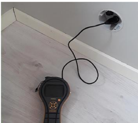
Rom under terreng (kjeller, underetasje, sokkeletasje) - [Hulltaking og fuktmåling i rom under terreng - Soverom]
