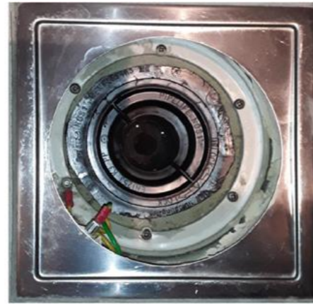
Våtrom - [Sluk - Bad]
