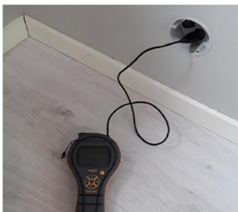
Rom under terreng (kjeller, underetasje, sokkeetasje) - [Hulltaking og fuktmåling i rom under terreng - Soverom]
