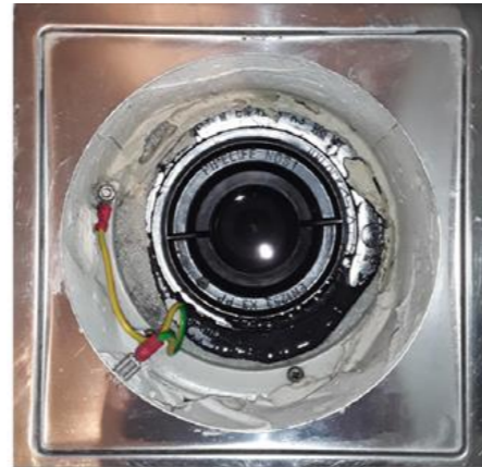
Våtrom - [Sluk - Vaskerom]
